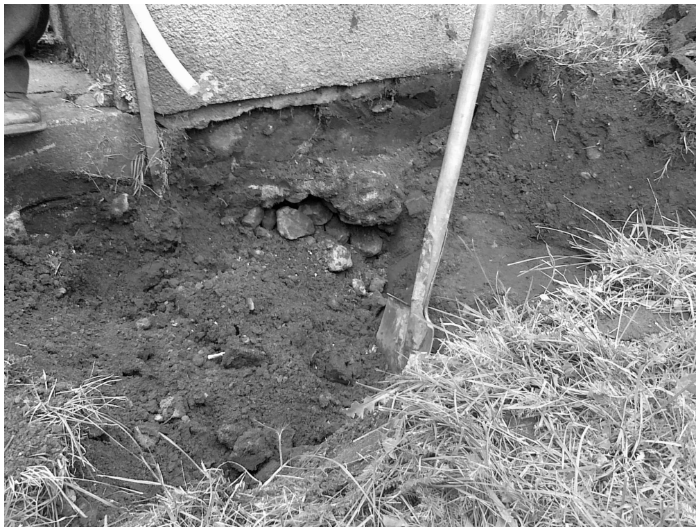
Odkrywka fundamentu
