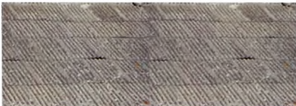
Rys. 5 Płyty faliste - eternit
