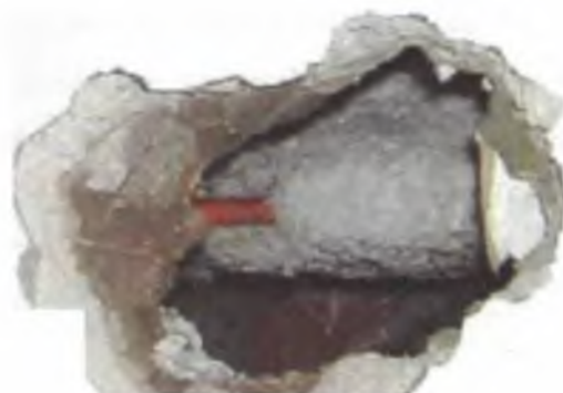
Rys. 7 Azbestowa izolacja rury
